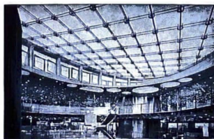
Das Atrium ist wesentlicher Bestandteil des Klimakonzeptes im Bürohaus Gniebel
