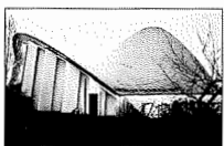
Die Dachkonstruktion der St. Suitbert-Kirche in Essen besteht aus einer bogenartigen, hyperbolischen Paraboloidschale mit 38 Metern Spannweite
