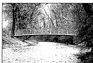
Fußgängerbrücke über die Gera aus Leichtbeton mit vorgespannten Betonstäben aus hochfestem Beton
