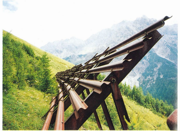
9, 10 Schneebrücken im Bschlaber Tal mit dem Detail des bergseitig zugbeanspruchten Fußpunktes
