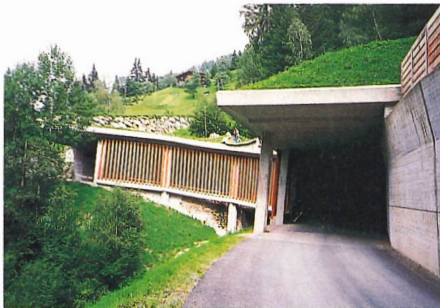
11 Die Lärchenholzbekleidung an der Stiertobelgalerie im Paznauntal verhindert, daß sich aufstauende Schneemassen in die Galerie gelangen
