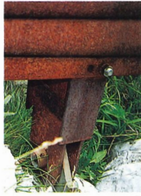
9, 10 Schneebrücken im Bschlaber Tal mit dem Detail des bergseitig zugbeanspruchten Fußpunktes
