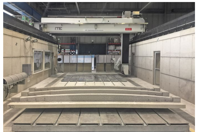
Bild 9 Hybrid gefertigtes bewehrtes Plattenbalkenelement aus einer 6 cm dicken betonierten Platte mit Flächenbewehrung und aufgedruckten Rippen mit veränderlichem Querschnitt Hybrid reinforced slab beam element made of a 6 cm thick concrete slab with surface reinforcement and printed ribs with variable cross section
