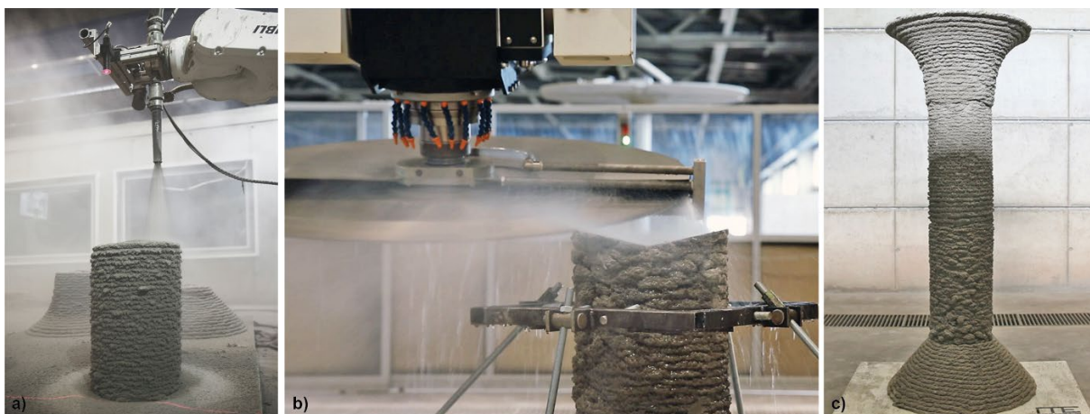
Bild 5 a) Spritzen von Betonhohlstützen im SC3DP-Verfahren, b) CNC-Schneiden der Fugengeometrie, c) vorgespannte, aus vier Segmenten trocken gefügte Betonstütze a) Printing of hollow concrete columns using the SC3DP technology, b) CNC cutting of the joint geometry, c) pre-stressed concrete column, dry joined from four segments
