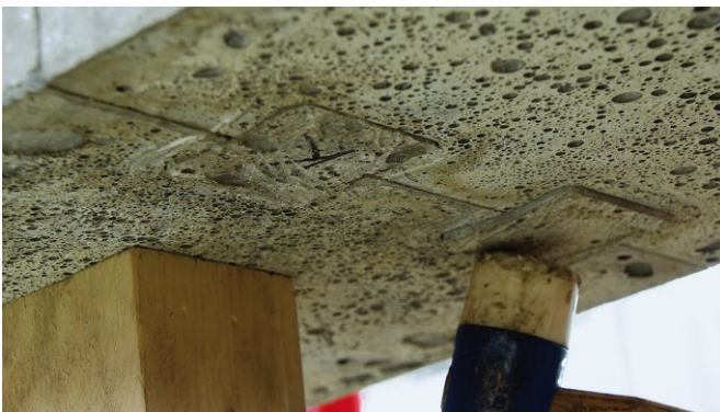
Bild 10 Fügung mit UHPFRC-Passstücken auf der Unterseite des Plattenbalkens in der Zugzone Joining with UHPFRC inlays under the T-beam in the tension zone
