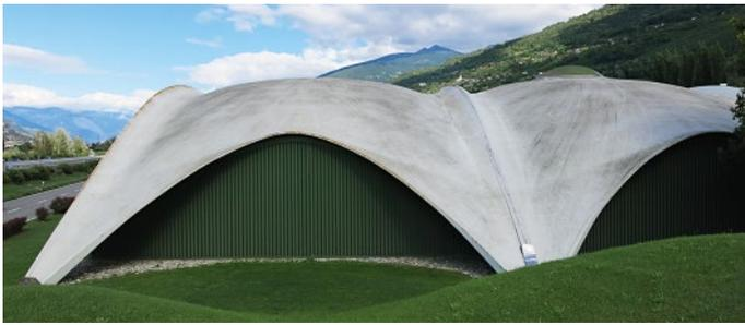
**Bild 12.** Tennishalle als Betonschalenkonstruktion in Sion. Entwurf und Tragwerk: Heinz Isler, 1983
