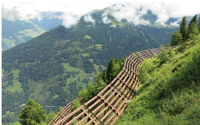
Bild 8. Stahlschneebrücken im Wallis
