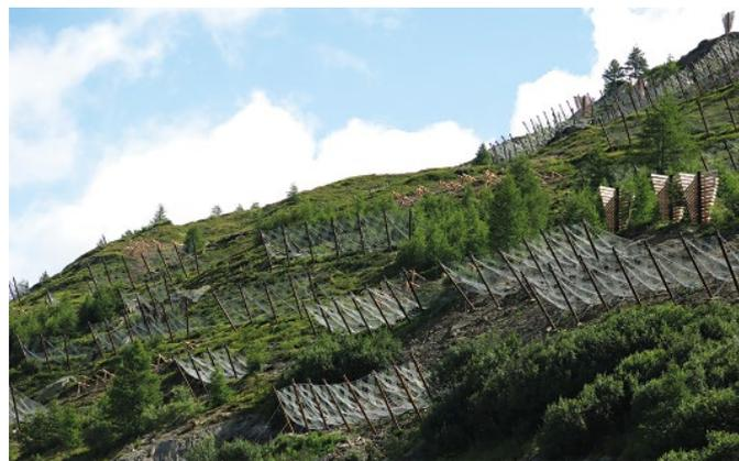
Bild 9. Schneenetze am Simplonpass
