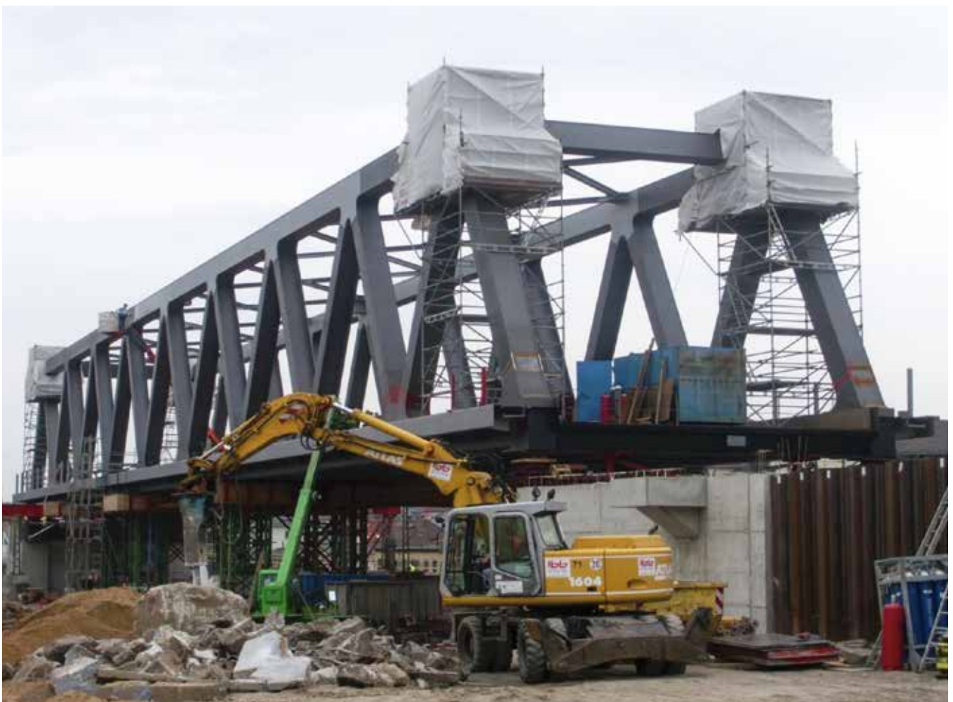
Abbildung 1: Kreuzungsbauwerk, Dresden-Neustadt [Quelle: IMO Leipzig]
